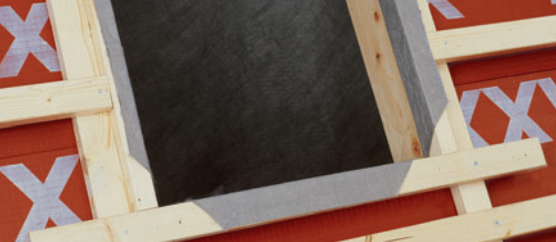
Detail osazení střešního okna.
