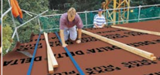
Podtěsnění kontralatí pomocí pásky DELTA®-SB 60.
